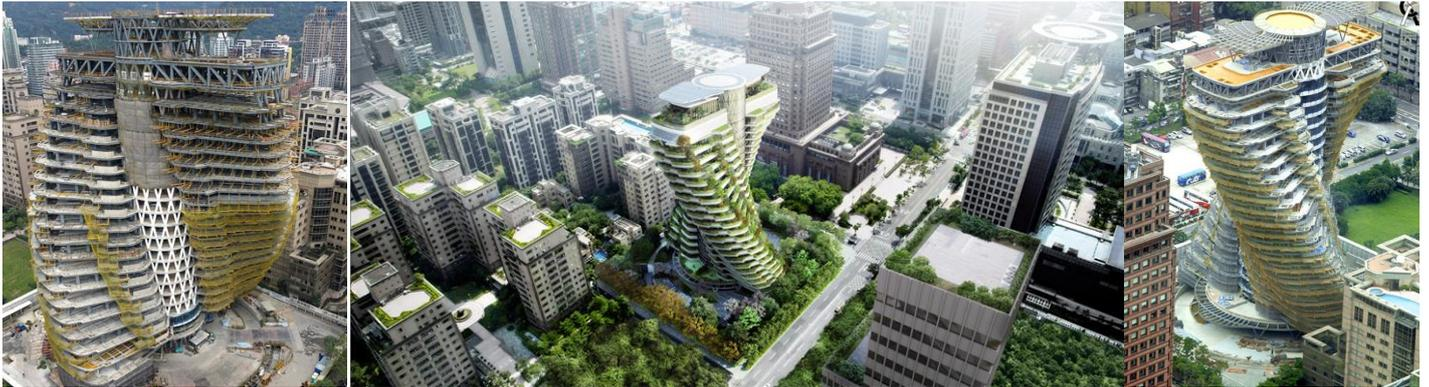
La torre tiene **20 pisos de altura** y está formada por **dos bloques** que dibujan una geometría helicoidal, **inspirada** en la estructura en doble hélice del **ADN**. Cada nivel rota  $4,5^\circ$  respecto al anterior, lo cual hace que la torre realice un giro de  $90^\circ$  desde su base hasta la parte más alta.
